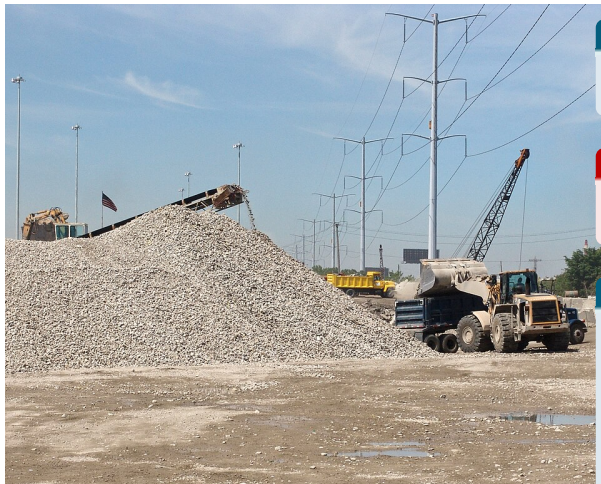
Planta de trituración de concreto de demolición. Foto: ChicagoConcrete, Wikimedia Commons, CC BY-SA
